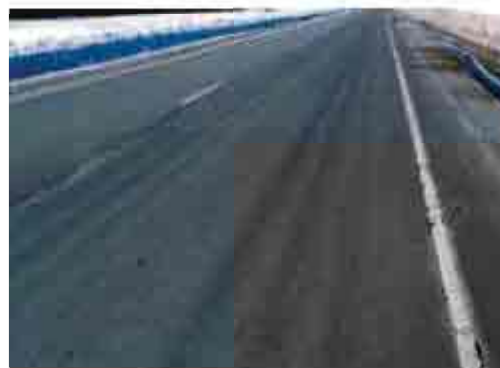
Figure II-8 ondulations à courte longueur d'onde
