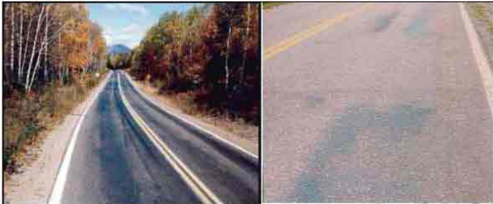
Figure II-9 : les ressuauges
