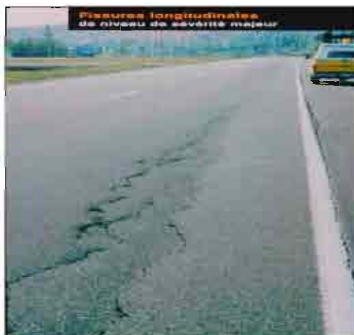
Figure II-2 Fissurations longitudinales
