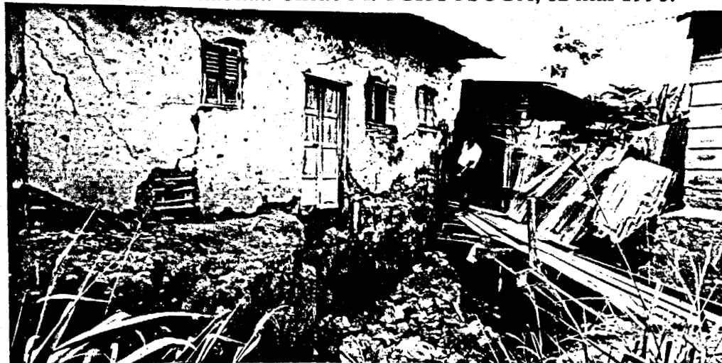
Photo 2.- Une maison "déchaussée" par une ravine au quartier Briqueterie-ouest . Cette entaille sert, également de dépotoir. Cliché B. DOUANLA, 07 novembre 1990.
