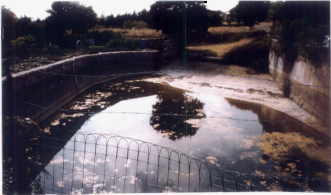
Figure 7 . Une citerne cimentée qui sert à l'abreuvement des troupeaux de moutons ou à l'irrigation d'un petit jardin de bas-fond.
