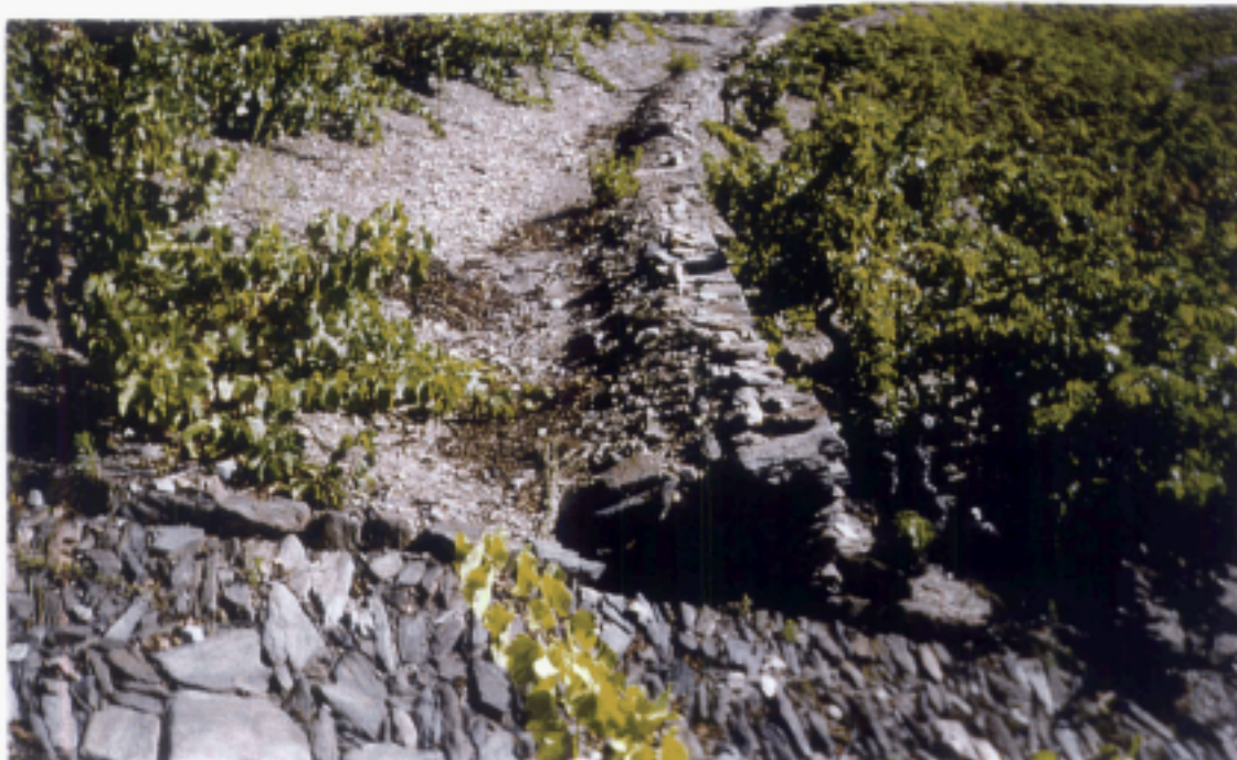
Fig.3. Drainage : une rigole en amont du mur et des drains empierrés : agouilles en peus de gal.
