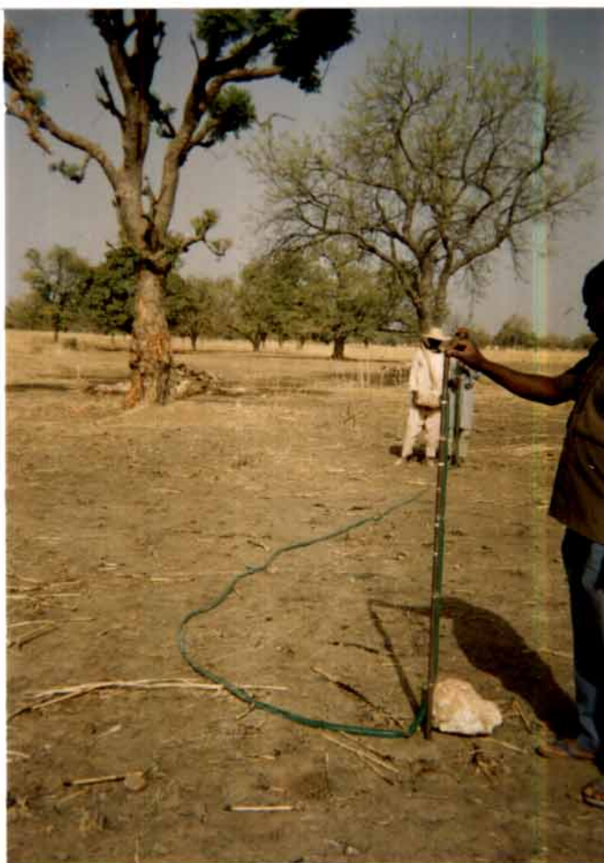
Planche 2: Séance de traçage de courbes de niveau pour la confection de diguettes filtrantes
