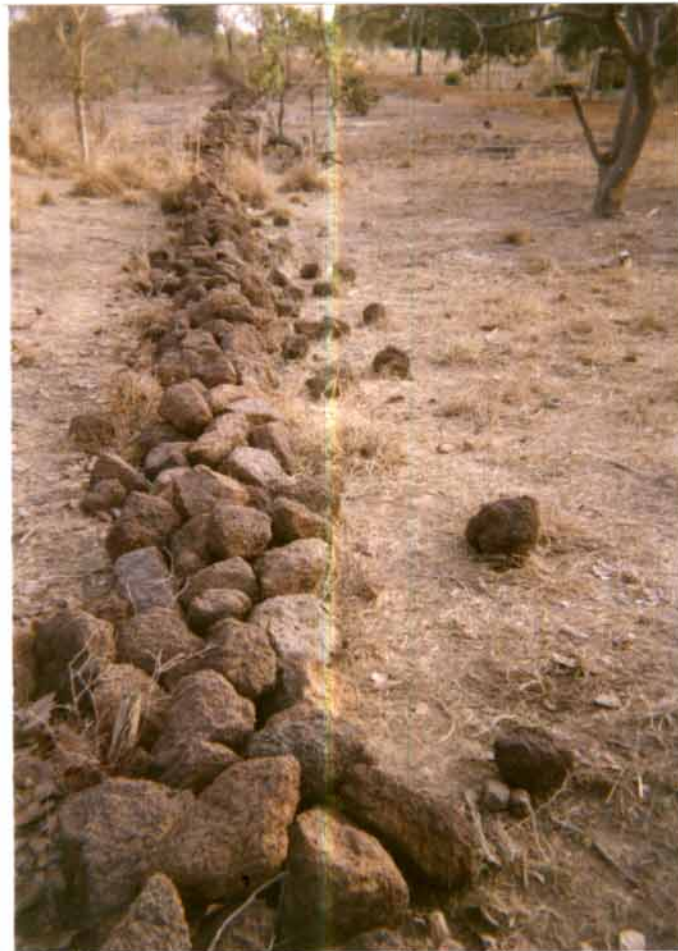
Planche 8: Vue d'une diguette filtrante confectionnée à l'aide de "cailloux sauvages".
