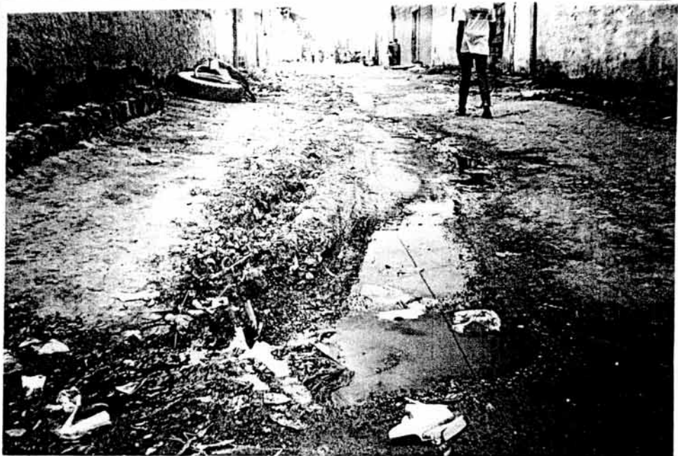
QARTIER ZANCOUETTIN : Rigoles d'eaux usées des douches s'écoulant dans la rue
