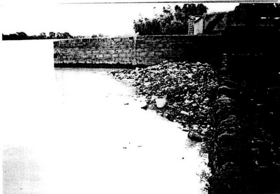
QARTIER DAPOYA : Abord du barrage n°2 Insuffisance dans l'aménagement ou avidité du propriétaire ?
