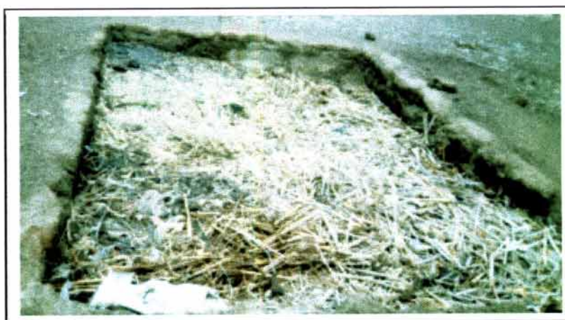
Image 2 – Terroir de Dakonsin : Réalisation d'une fosse fumière
