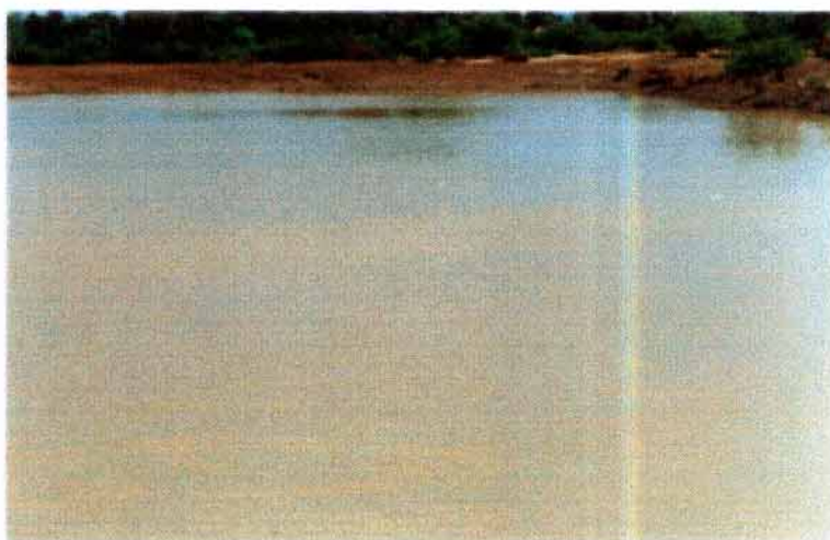
Photo VII : Ce bouli permet de résoudre le manque d'eau
