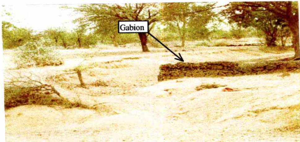
Photo 19 : Digue filtrante à Nongo. Nous pouvons remarquer la déviation du cours inférieur du ravin par rapport au gabion. Cette situation s'explique probablement par l'ancienneté de l'implantation du dispositif. 25/05/97.
