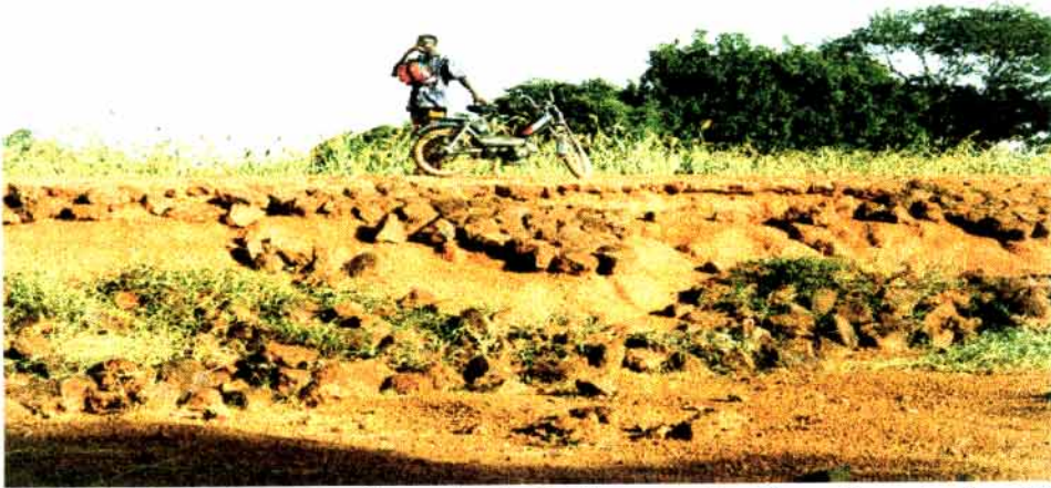
Photo 11 : Rigole sur les versants du remblai de l'axe routier Kaya-Barsalogho. 30/10/97.
