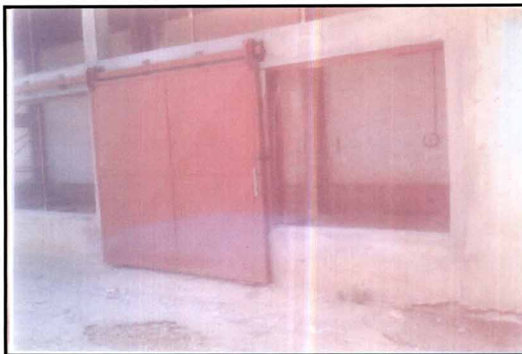
Photo 7 : Réfection de la salle des machines
