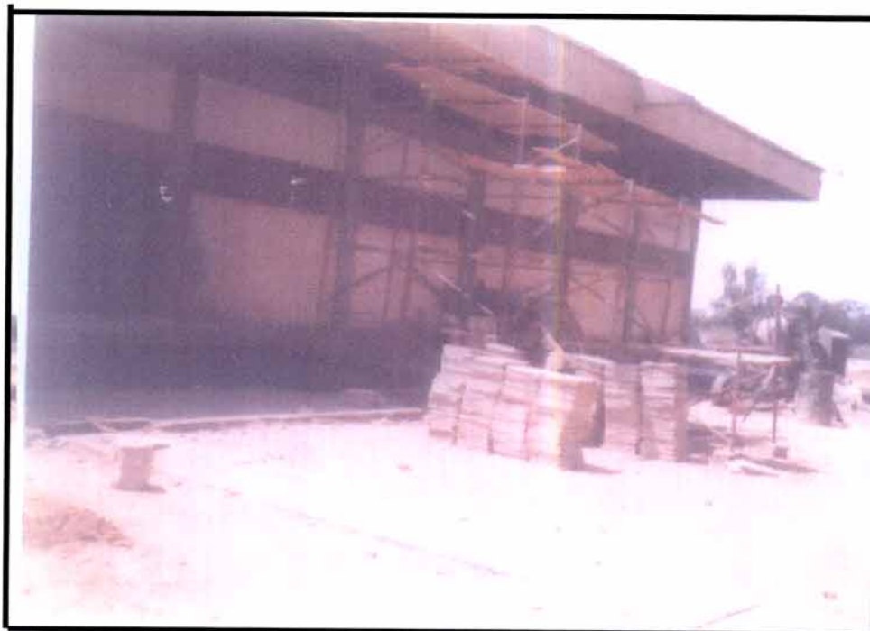
Photo 6 : Réfection du toit et du bâtiment
