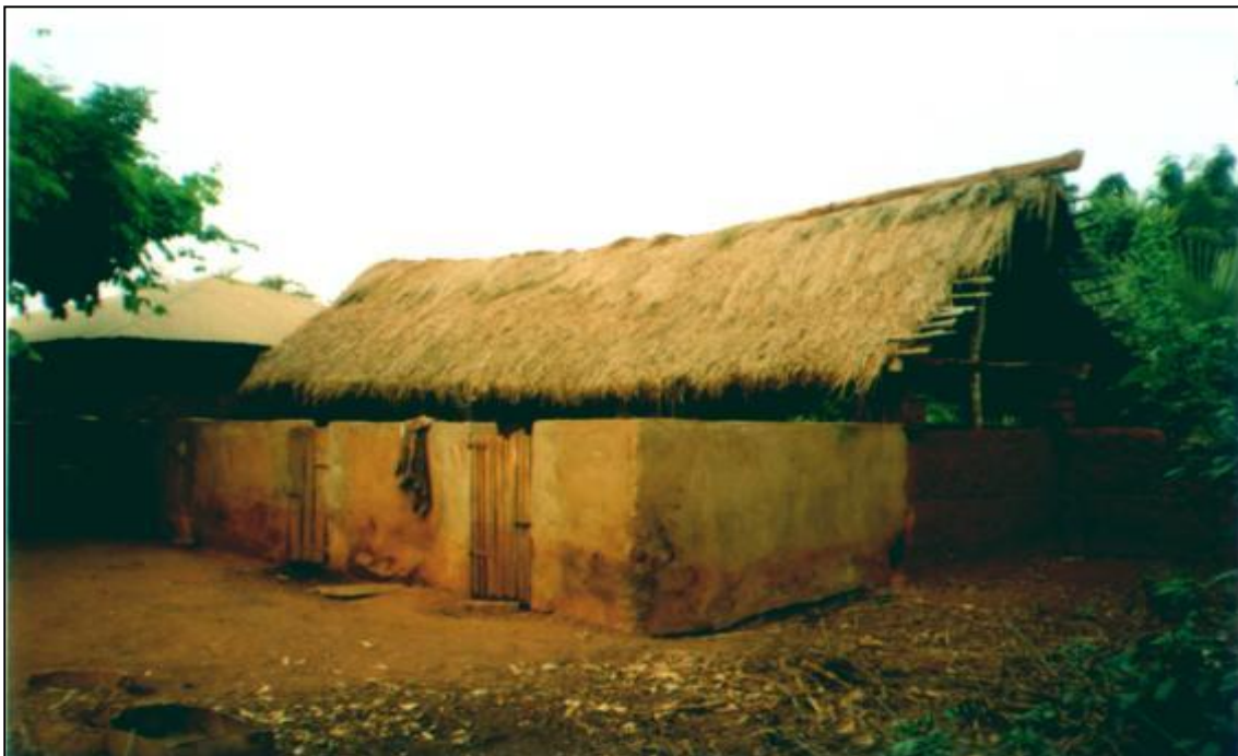
Photo 4a : Porcherie semi-moderne à murs en banco cimenté
