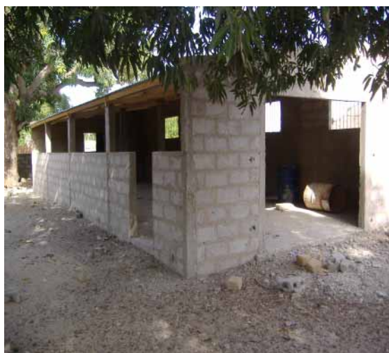
Photo 7 : Chevrerie de Mbassis en construction
