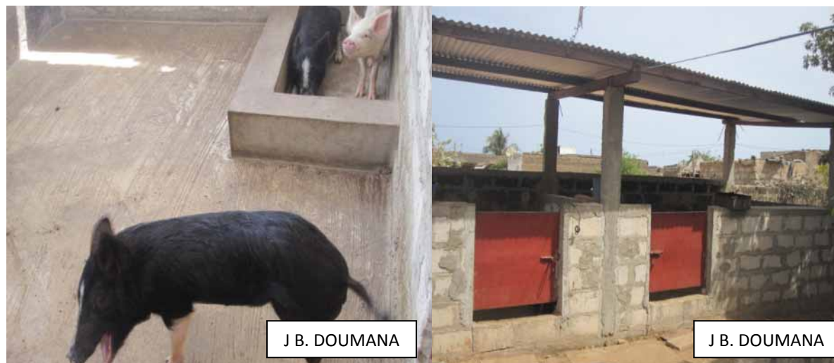
Photo 1 : Bâtiment amélioré au sol bétonné Photo 2 : Bâtiment amélioré avec toit en tôle
