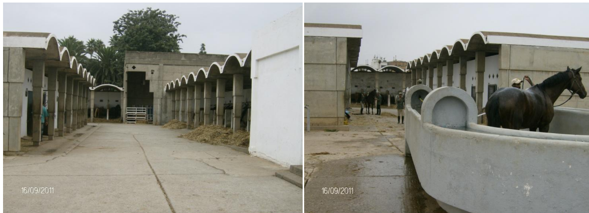
Figure 30 : Ecuries et aires de lavage des chevaux à l'E.R.C (Cliché BELGGHAZI N.)
