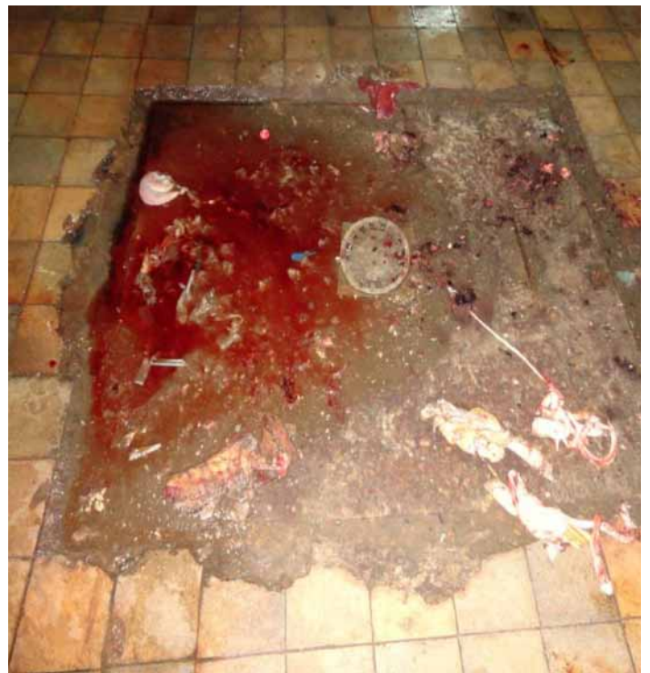
Figure 12: Siphons bouchés par des déchets et de l'eau sale
