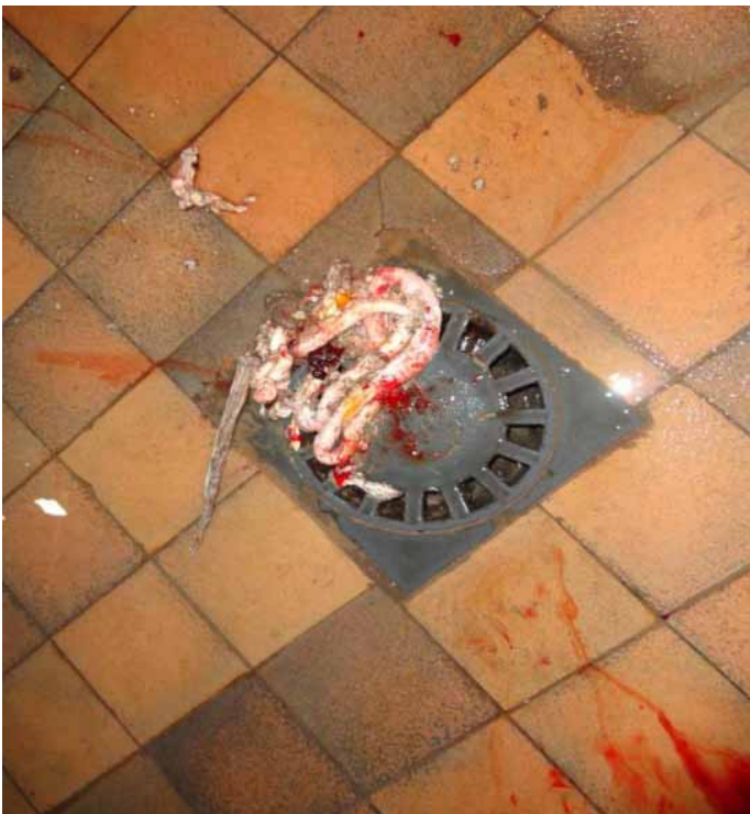
Figure 12: Siphons bouchés par des déchets et de l'eau sale
