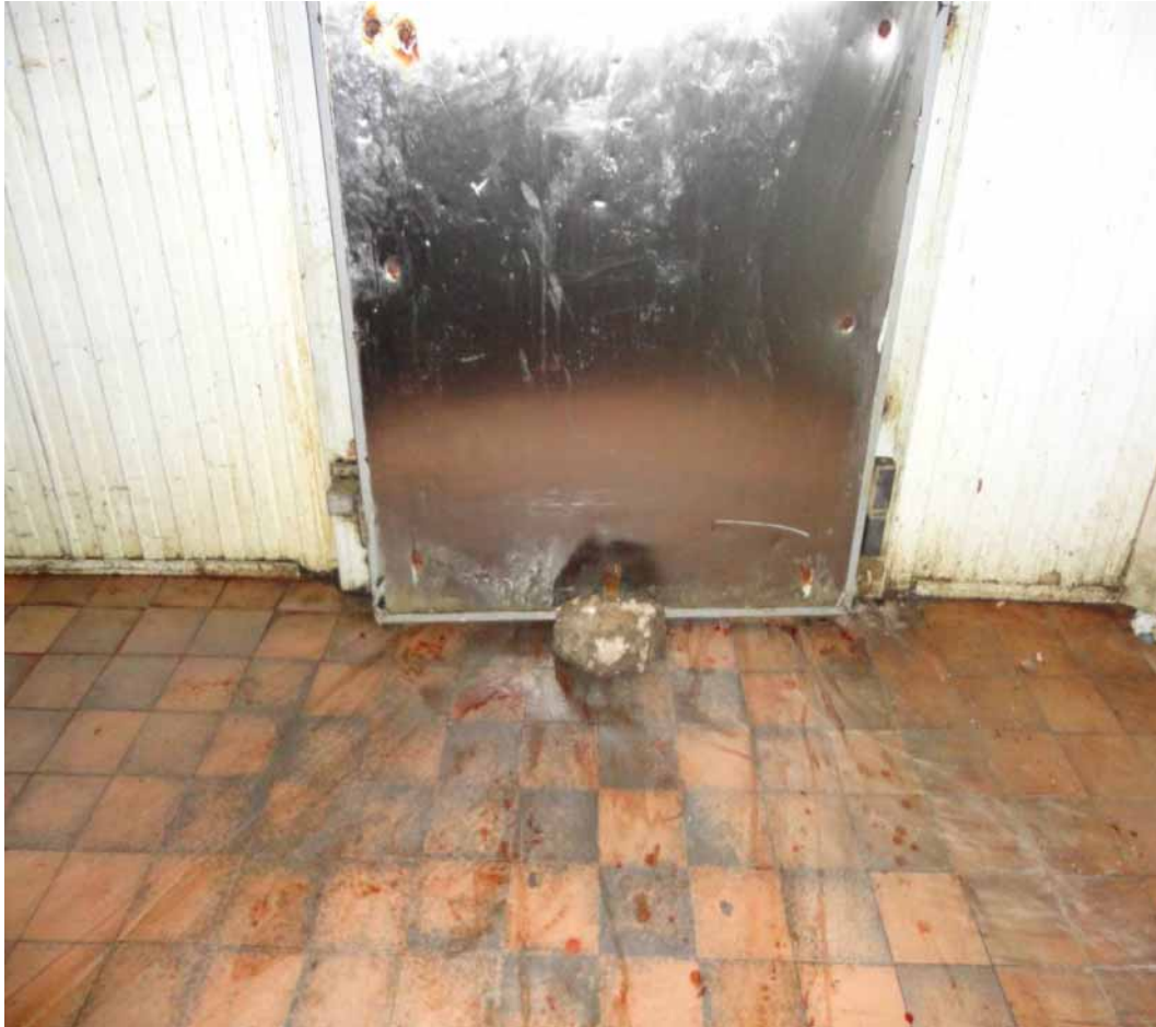
Figure 26 : Masse de pierre pour renforcer la fermeture de la porte (chambre froide)
