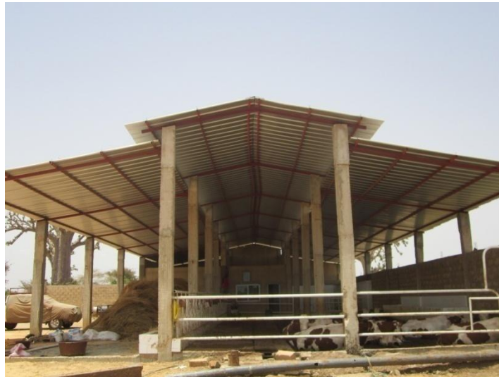
Figure 9 : Bâtiment en construction : étable de vaches Montbéliarde
