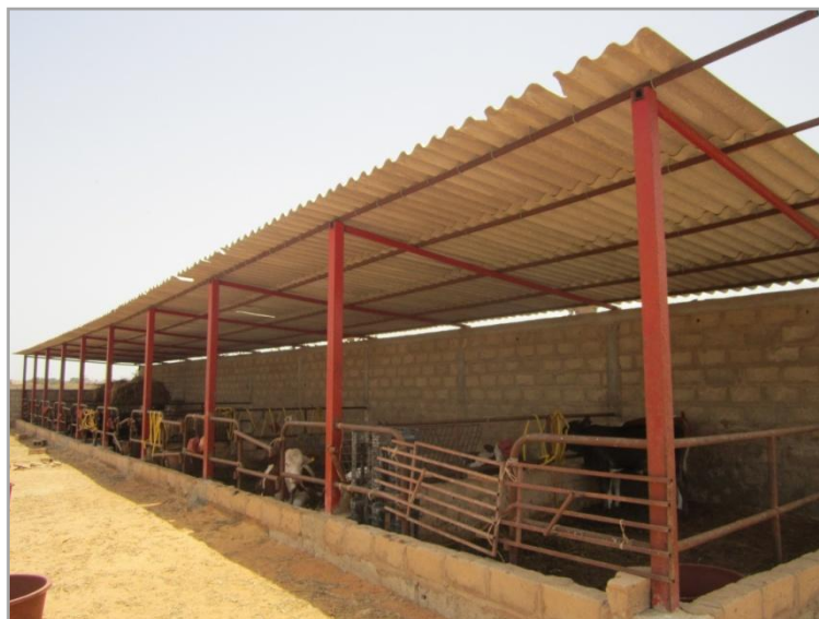
Figure 10 : Bâtiment provisoire : logement de vaches métisses et des veaux
