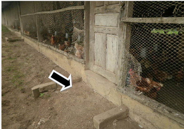
Figure 13: Absence de pédiluve à l'entrée du bâtiment
