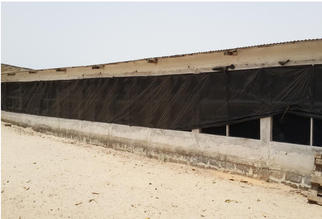
Photo 1: Vue extérieure du Bâtiment « A »
