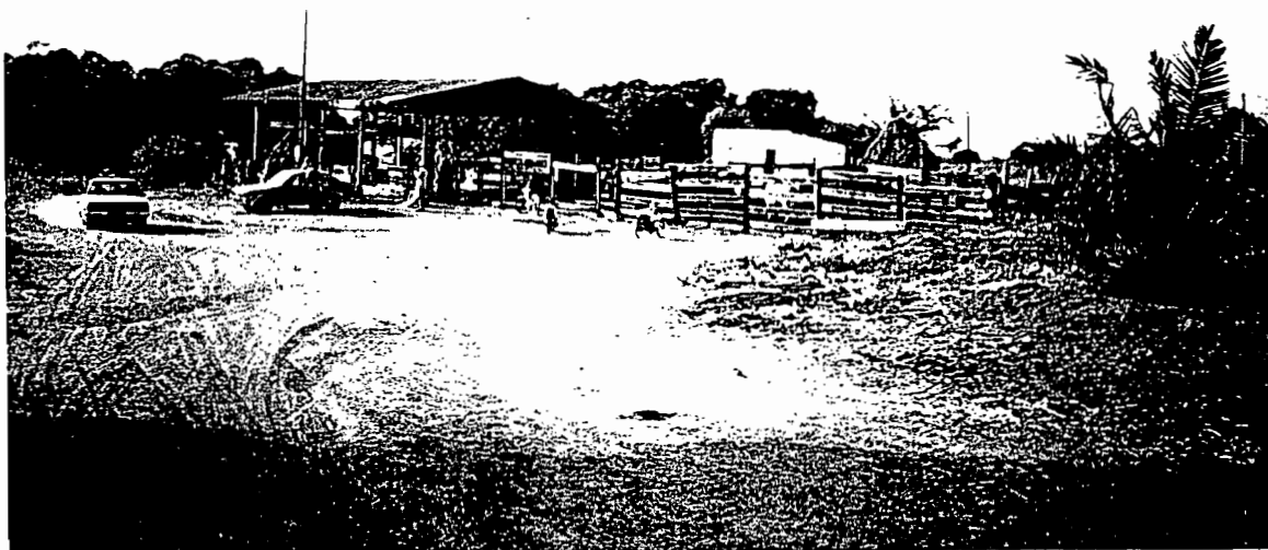
Fig.3 : Abattoir à structure métallique (Bondoukou)
