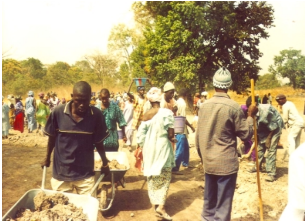
Travaux de construction de digues en Casamance (Sénégal)
