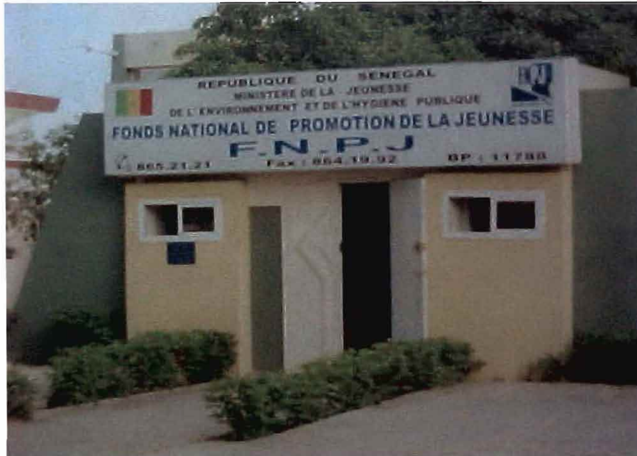
Photo 2 : façade du Siège FNPJ à Dakar
