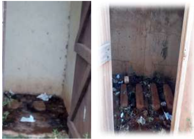
Latrines inutilisées dans deux écoles urbaines
