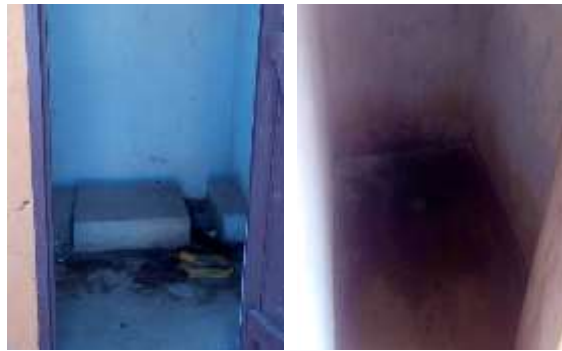
Latrines utilisées dans deux écoles urbaines
