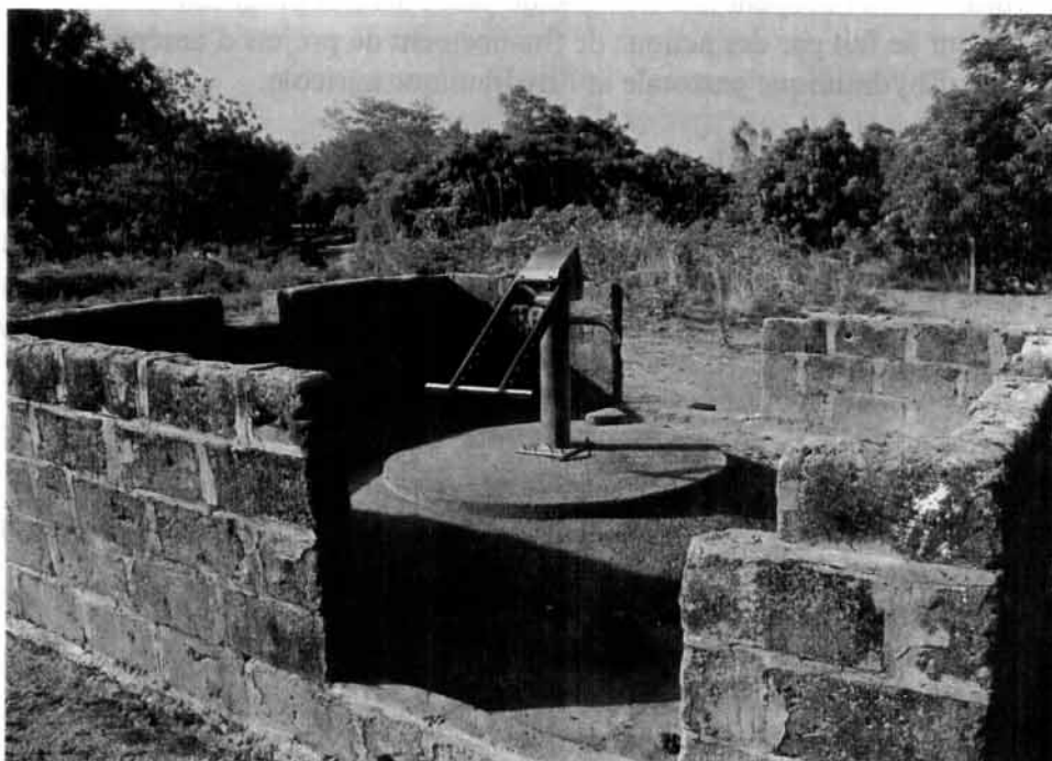
Point d'eau aménagé pour un approvisionnement en eau potable
