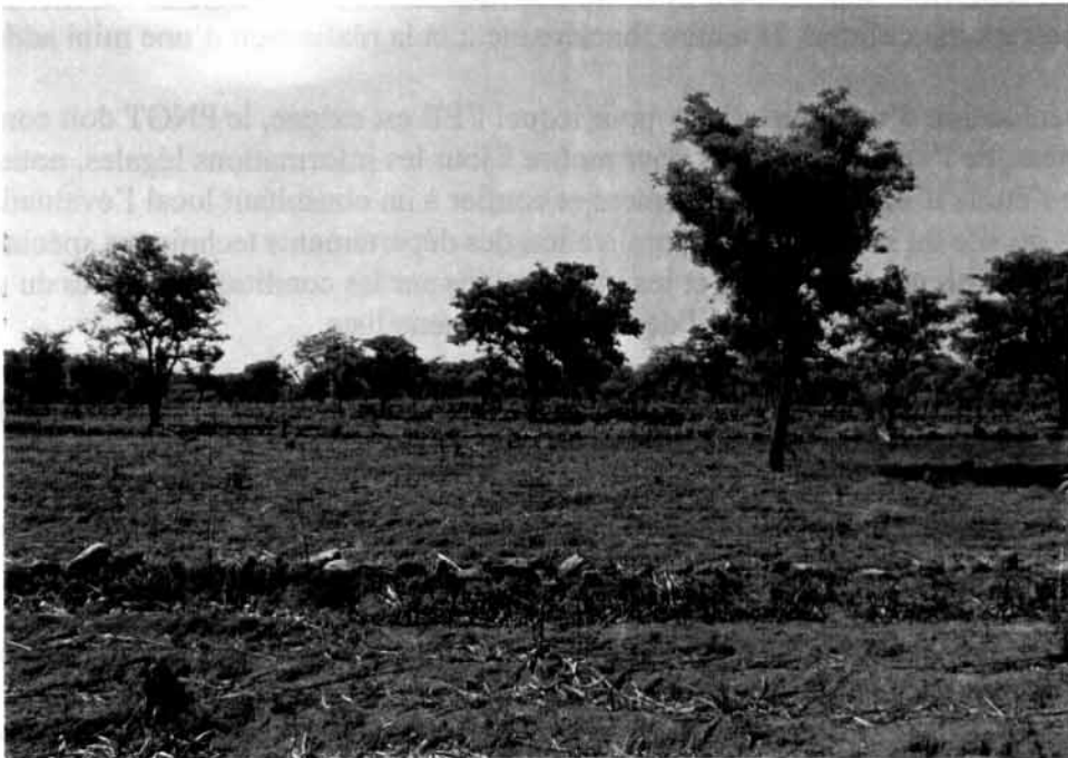
Ouvrage d'aménagement des sols, cordons pierreux
