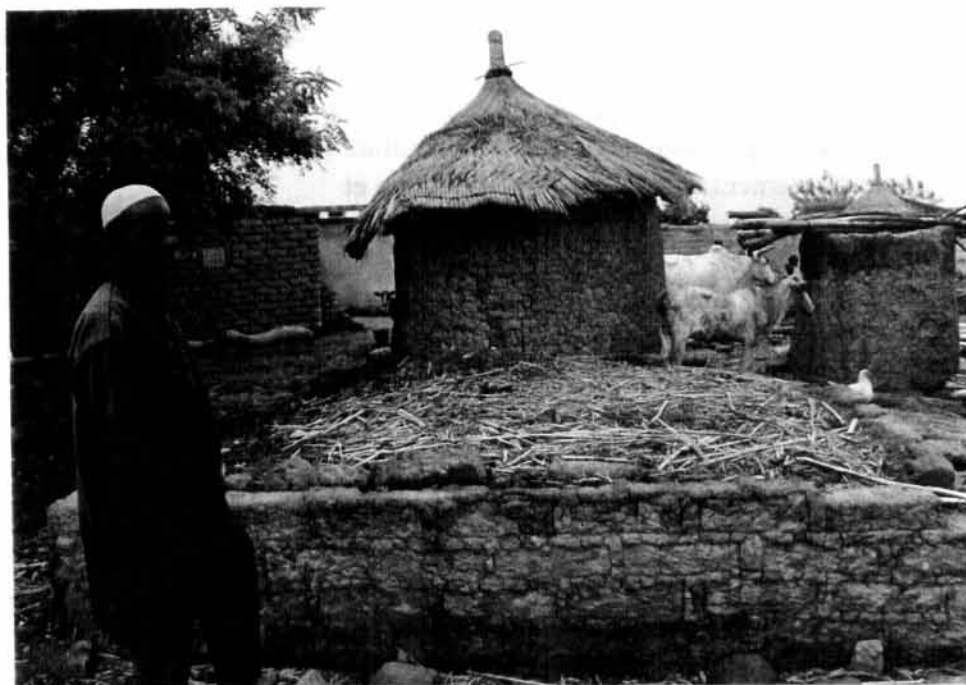
Réalisation d'une fosse fumière dans une ferme écologique dans la Province du Boulkiemdé
