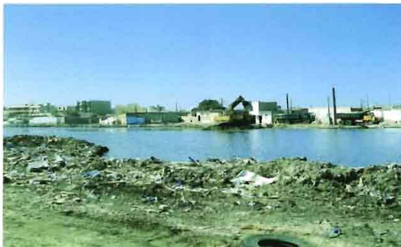
Photo n° 12 : travaux du bassin de Wakhinane Nimzatt
