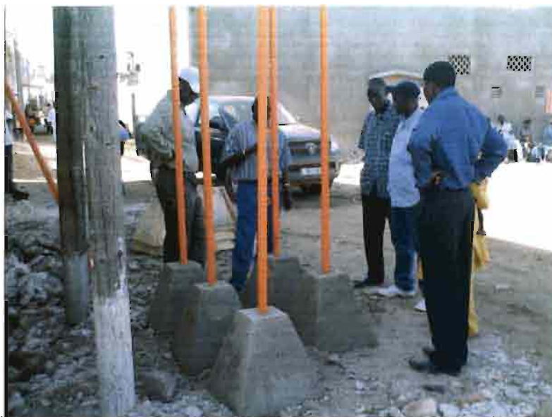
Photo n° 13 : les poteaux de clôture des bassins
