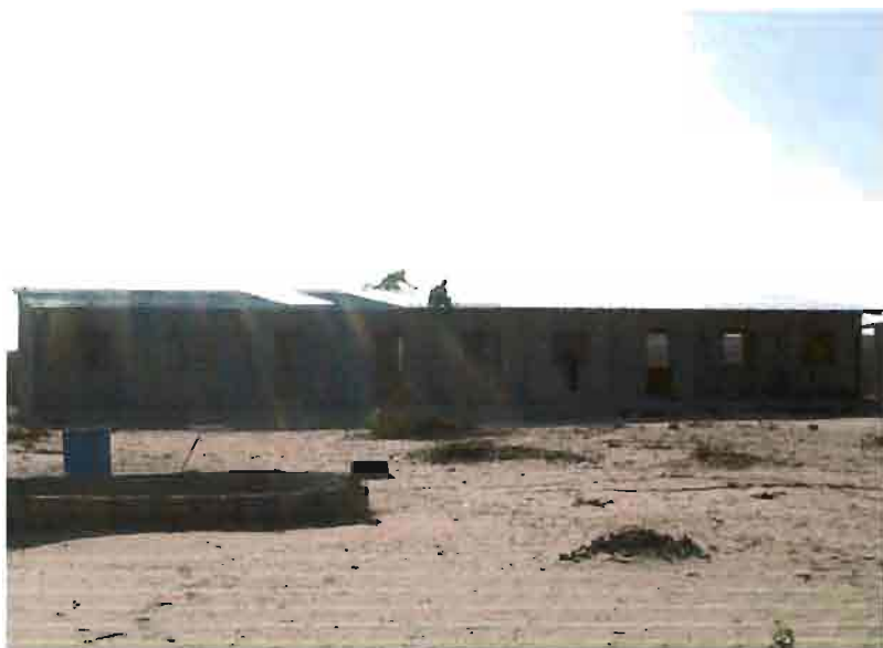
Photo n° 17: école élémentaire de l'unité 17 B en construction
