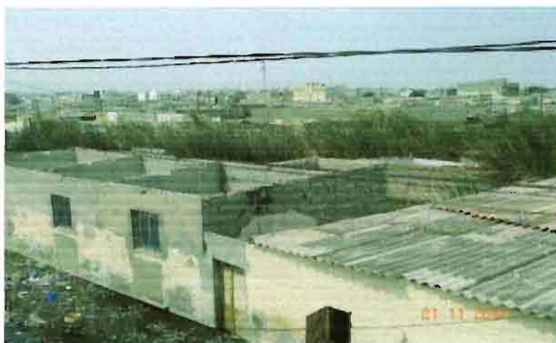
Photo n° 9 : début des démolitions : enlèvement des toitures des maisons
