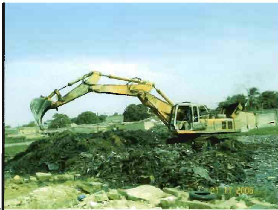
Photo n° 10 : déblaiement des zones de bassin
