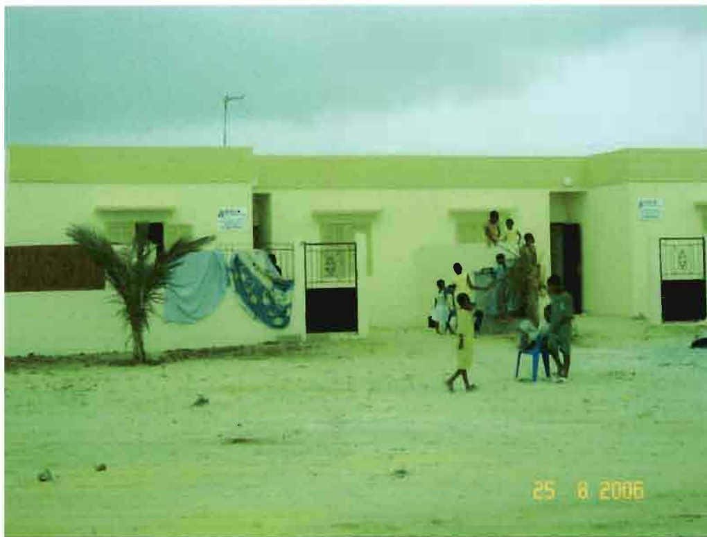
Photo n° 14 : les maisons Jaxaay construits par SIDAK
