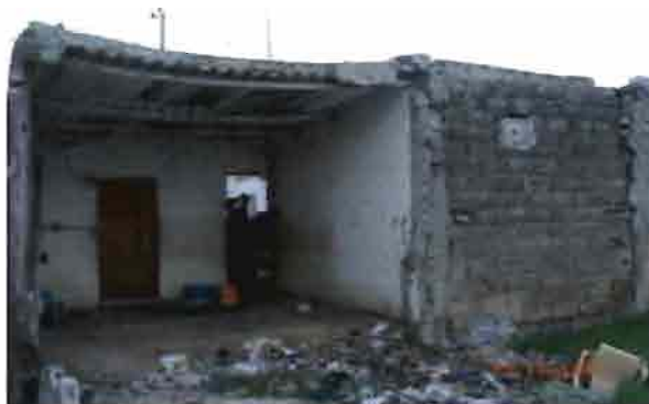
Photo n° 4 : cohabitation des populations avec les ordures dans les maisons inondées
