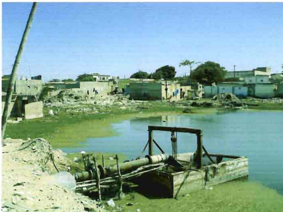
Photo n° 11 : début des travaux du bassin de Médina Gounass
