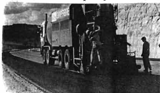
Coulage du Gripfibre sur la membrane rocade de Périgueux
