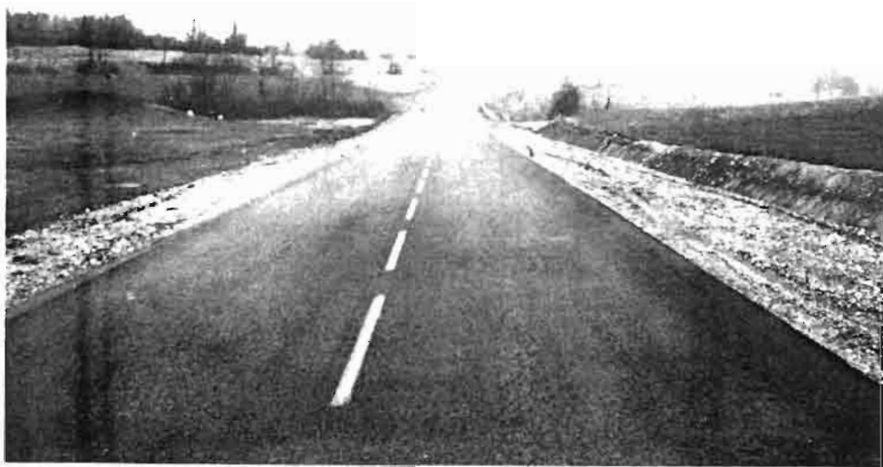
Après : chantier terminé
