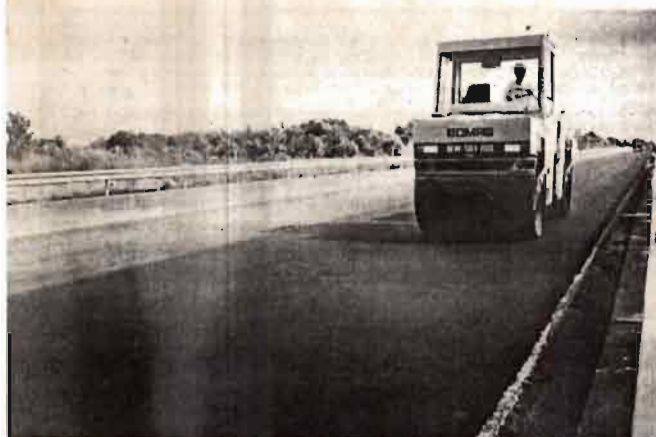
Photo 5 Compactage au compacteur à deux cylindres lisses
