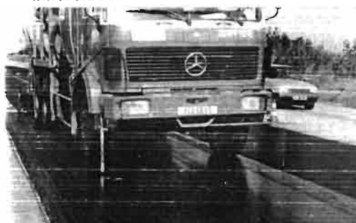
Coulage du Gripfibre sur la membrane Travail par demi-chaussée RN7 La Tour de Salvagny (Rhône)
