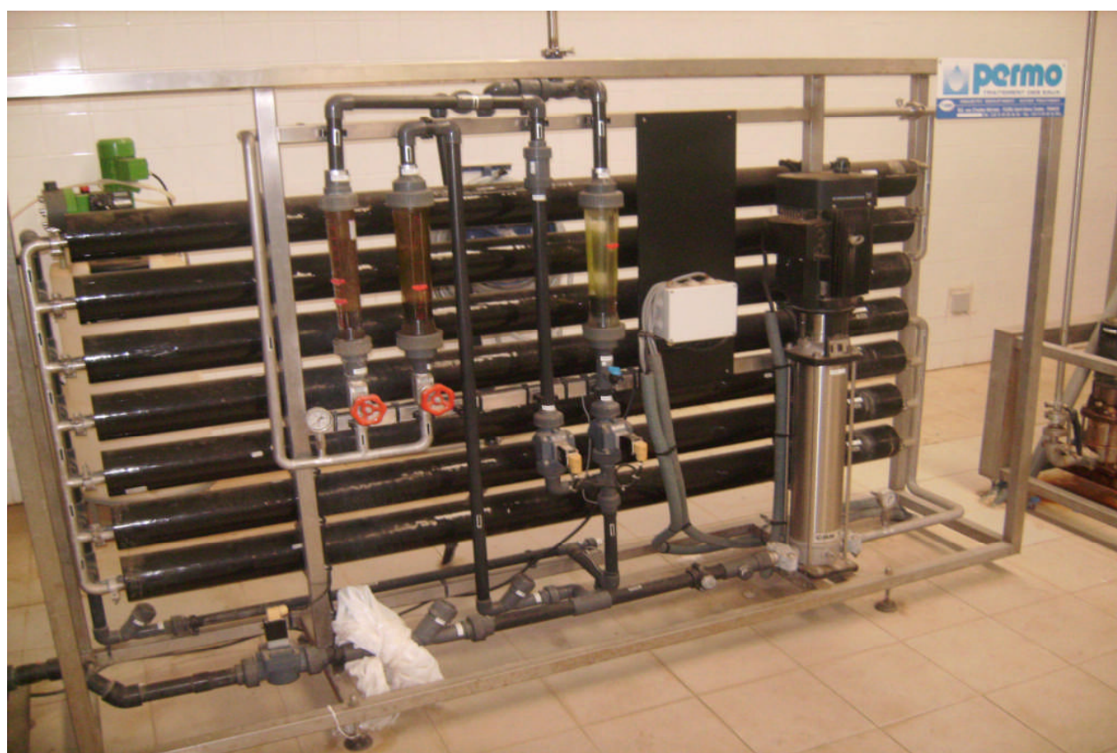
A4_5 : Système d'osmose inverse
