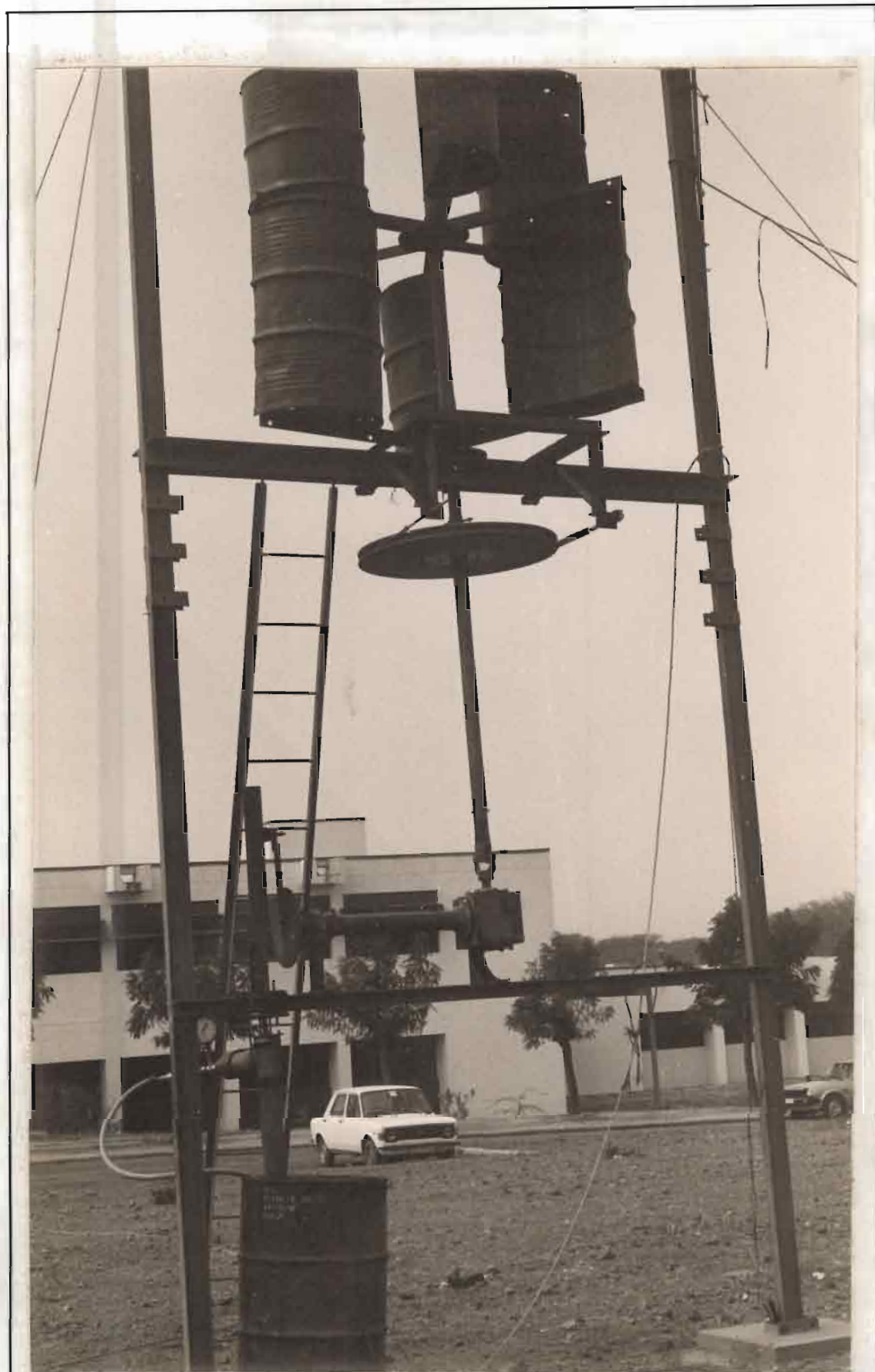
Fig. 12 Photo du système installé
