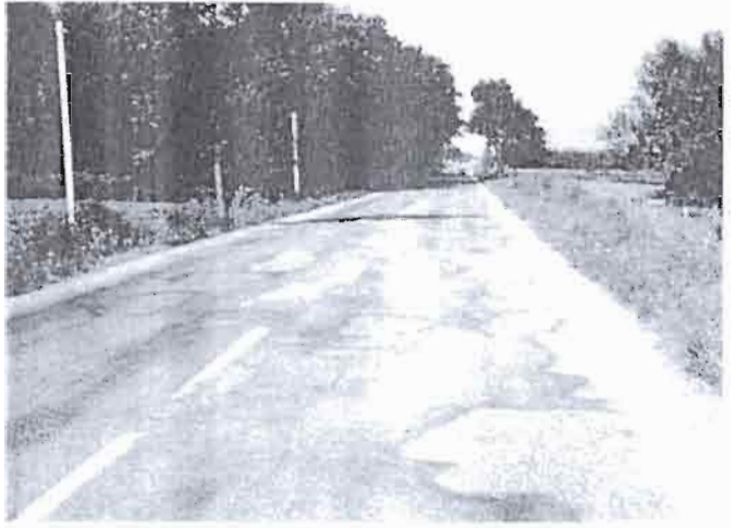
Photo 22 Réparation de la couche de roulement. « Point à temps » (défaut de type B)
