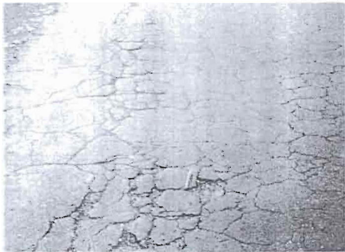
Photo 17 Faïencage à mailles moyennes Fissures franchement ouvertes
