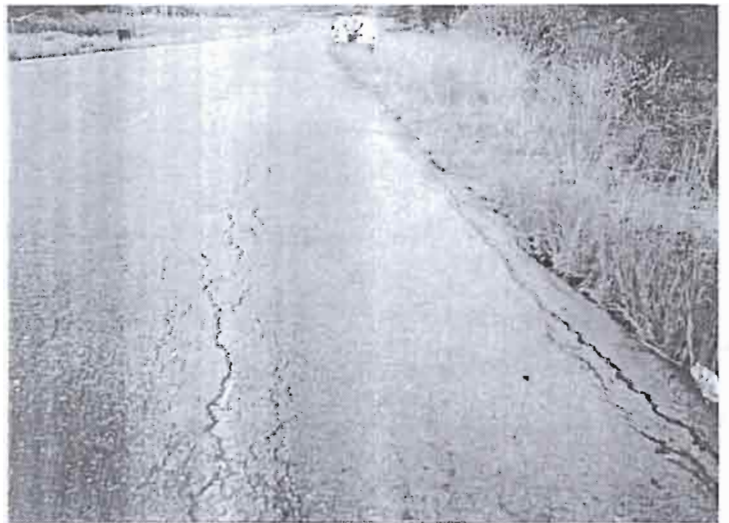
Photo 11 Fissure longitudinale franchement ouverte.
