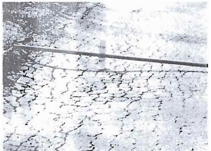
Photo 5 Bourrelet au centre de la chaussée d'épaisseur supérieure à 10 cm mais localisé.
