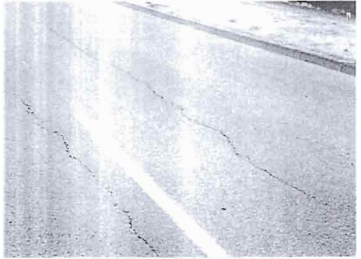
Photo 10 Fissures longitudinales.
