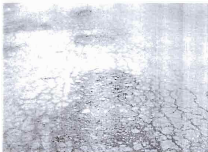
Photo 29 Nids-de-poule de faible profondeur et de faible surface mais en nombre important.
