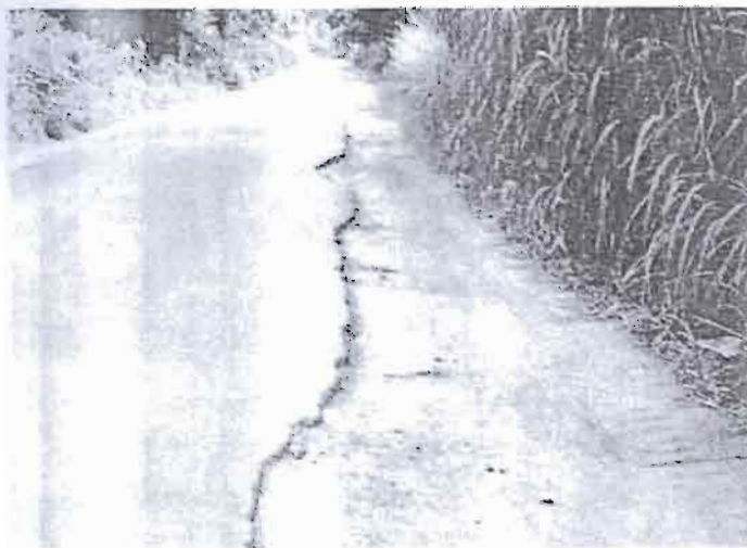
Photo 44 Forte dénivellée entre la chaussée et l'accotement (inférieure ou égale à 10 cm).
