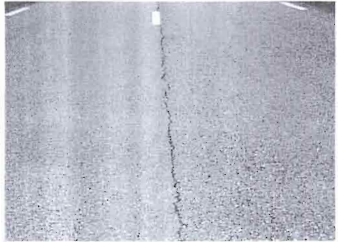
Photo 25 Fissure d'axe fine, unique et rectiligne
