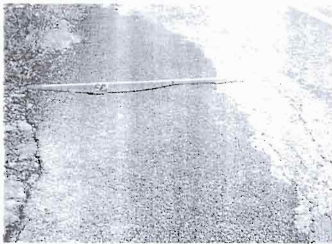
Photo 22 Réparation de la couche de roulement. « Point à temps » (défaut de type B)
