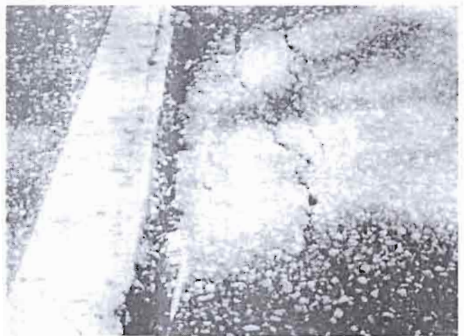
Photo 26 Fissure d'axe ramifiée, sans arrachements
