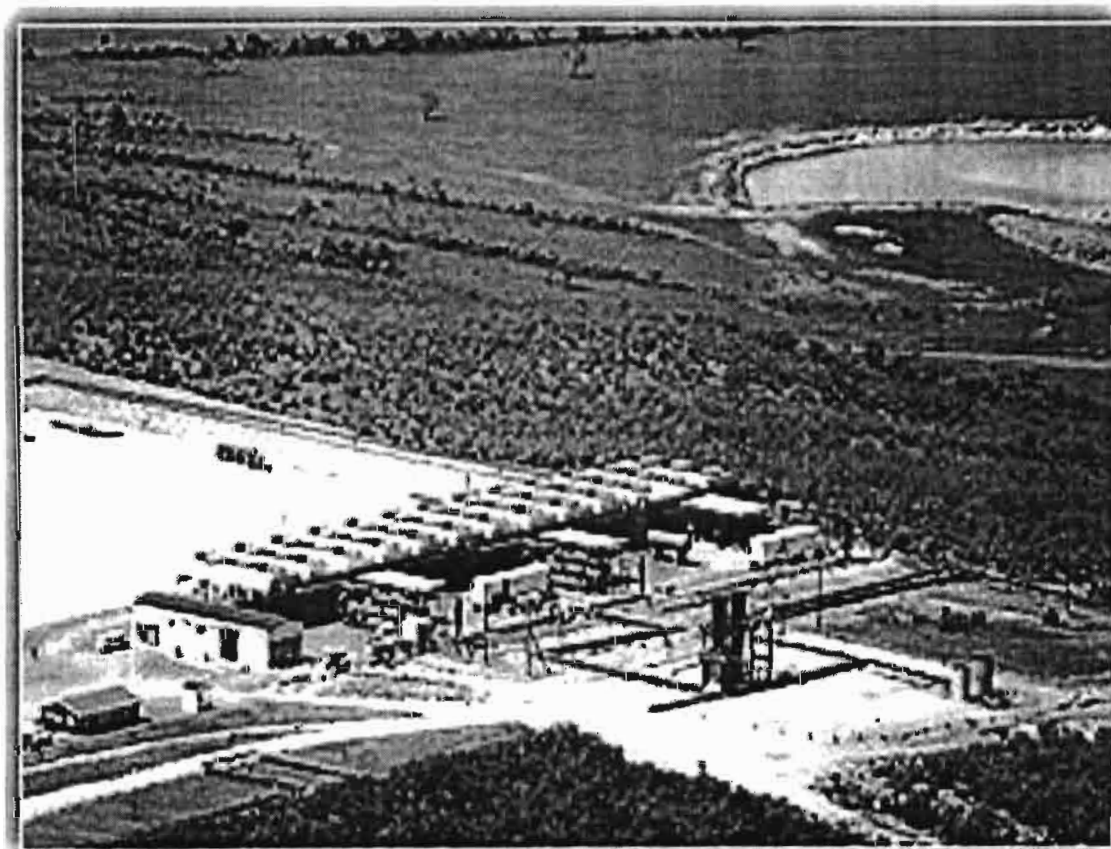
Centrale d'Olkaria III au Kenya (18MW)
