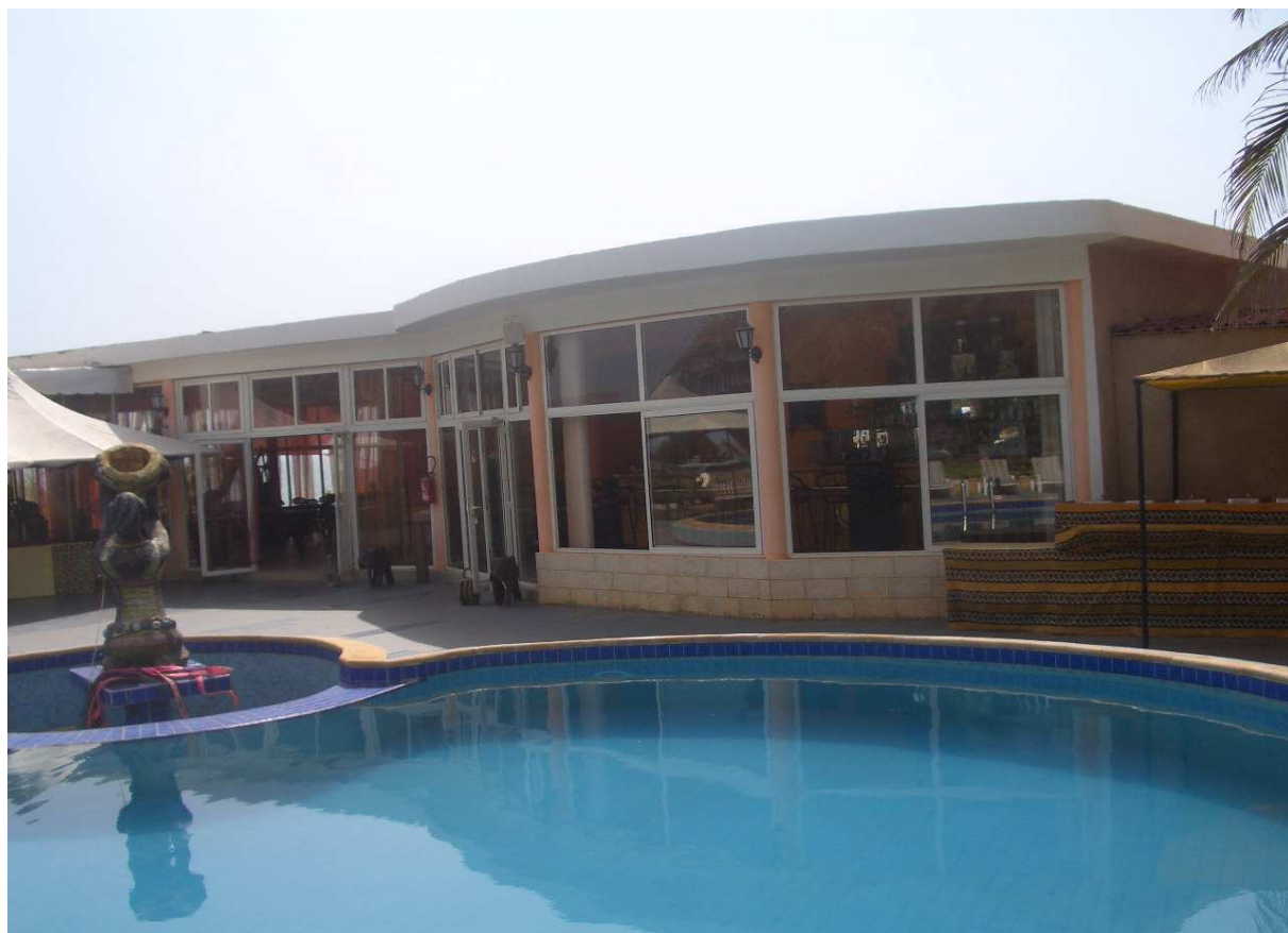
Figure XII: Photo du Bâtiment A
