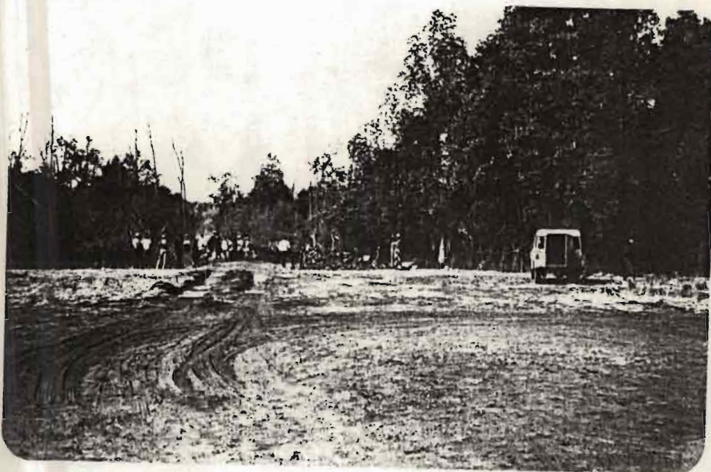
figure C.13 : Accès au barrage de Djinani
