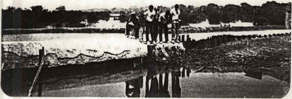
figure C.9 : barrage de Dianki buses d'évacuation
