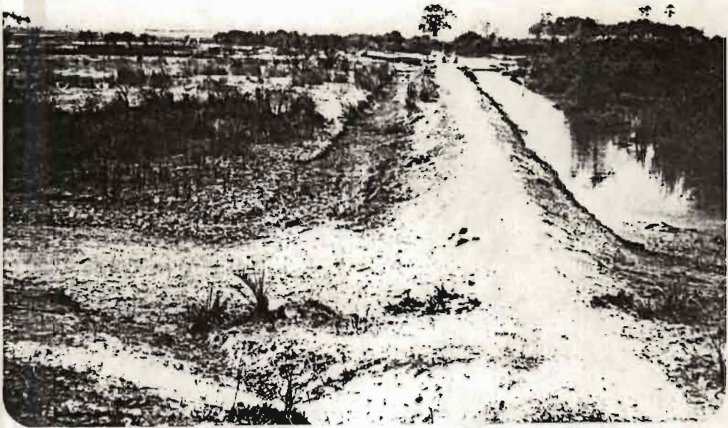
figure C.10 : barrage de Dianki bassin amont sec
