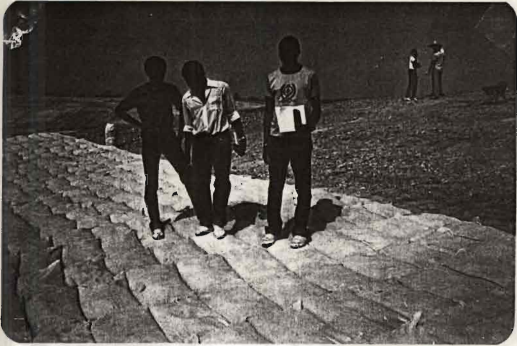
figure C.5: barrage de Guidel protection des talus
