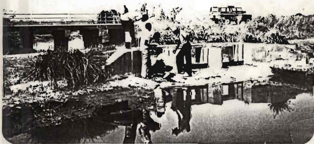
figure C.8: déversoir du barrage de Dianio
