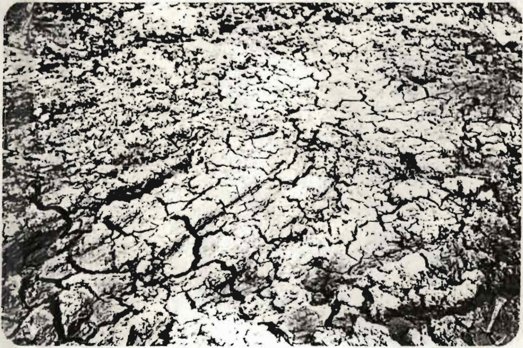
figure C.3: argile d'imperméabilisation barrage de Guidel
