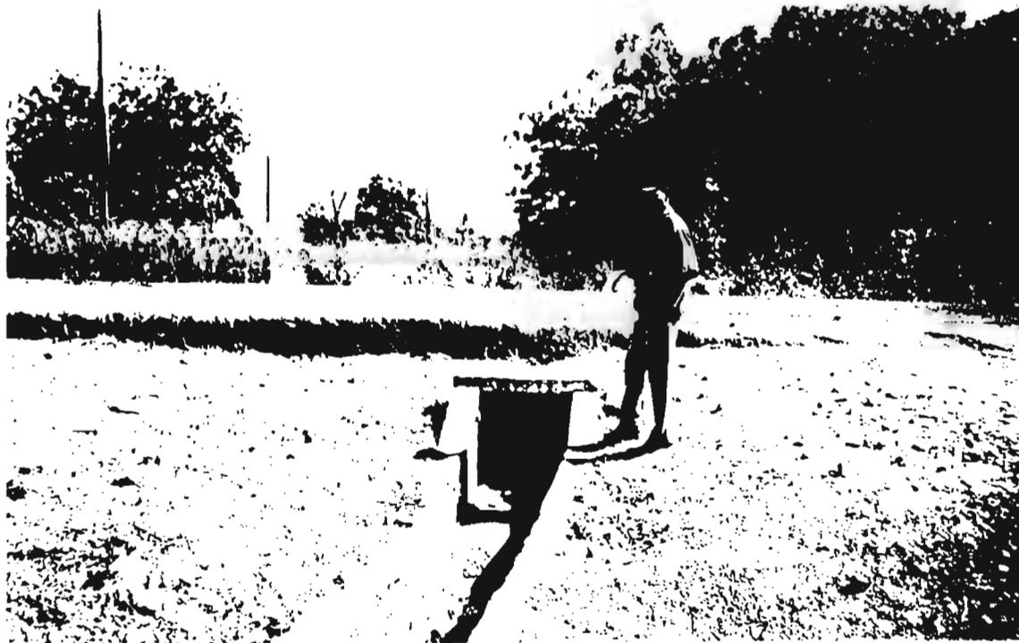
Buse de faible capacité pour l'évacuation des eaux.
