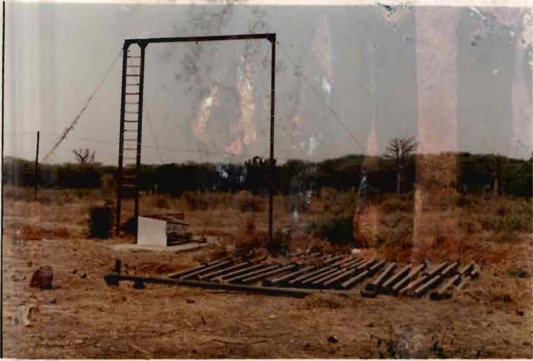
↑ Photo n°1 : EMBLACEMENT DU FORAGE PROPREMENT DIT
