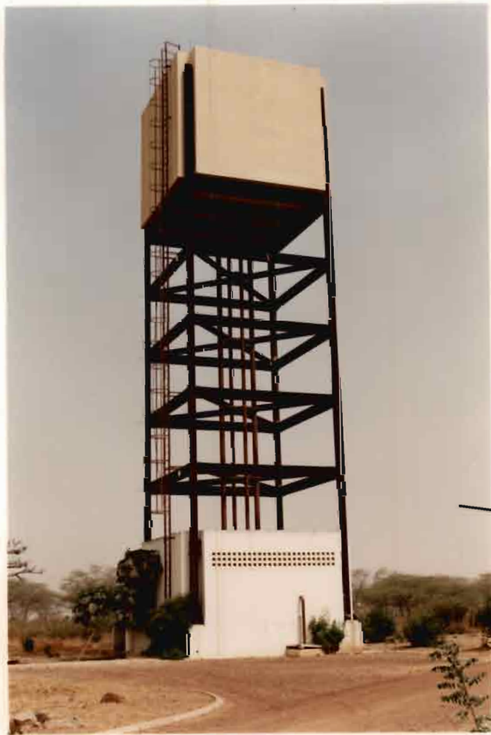
↑ Photo n°2 : VUE DU CHÂTEAU D'EAU
