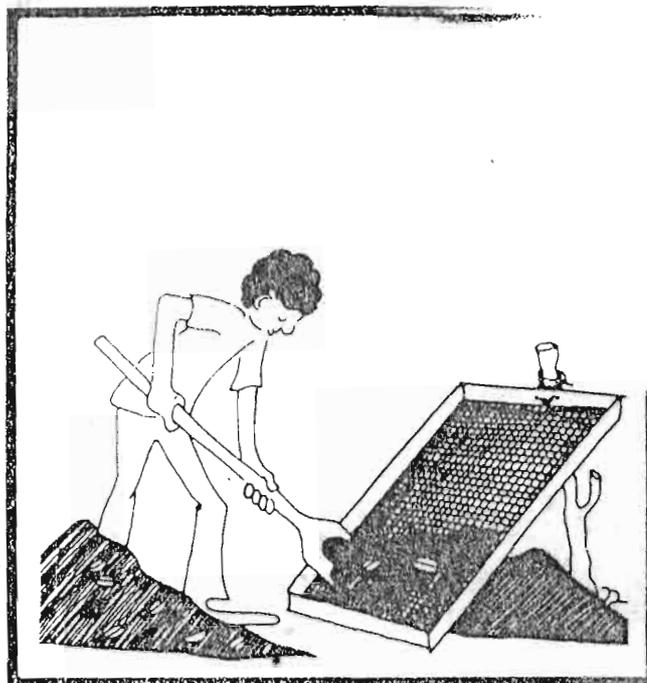
Et il faut aussi tamiser le sable qu'on utilisera. Il est préférable de balayer l'endroit choisi pour la préparation des matériaux.
