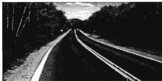
Figure 2.17 : Photo montrant le phénomène de ressuage sur une route revêtue.
