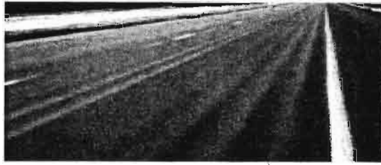
Figure 2.12 : Photo d'ornières à faible rayon sur une route revêtue.
