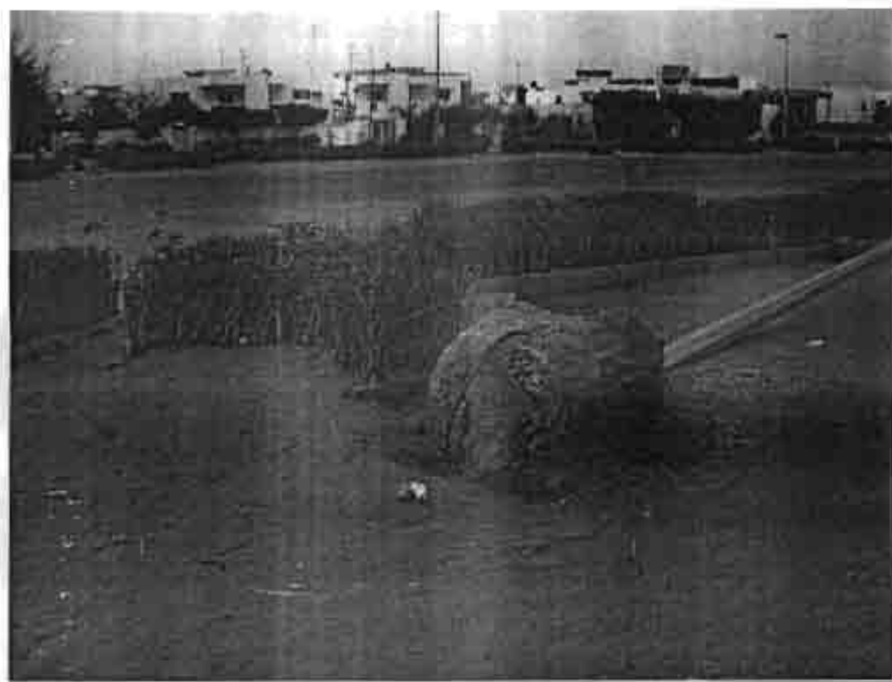
Candélabre arrachée avec son massif (VDN)
