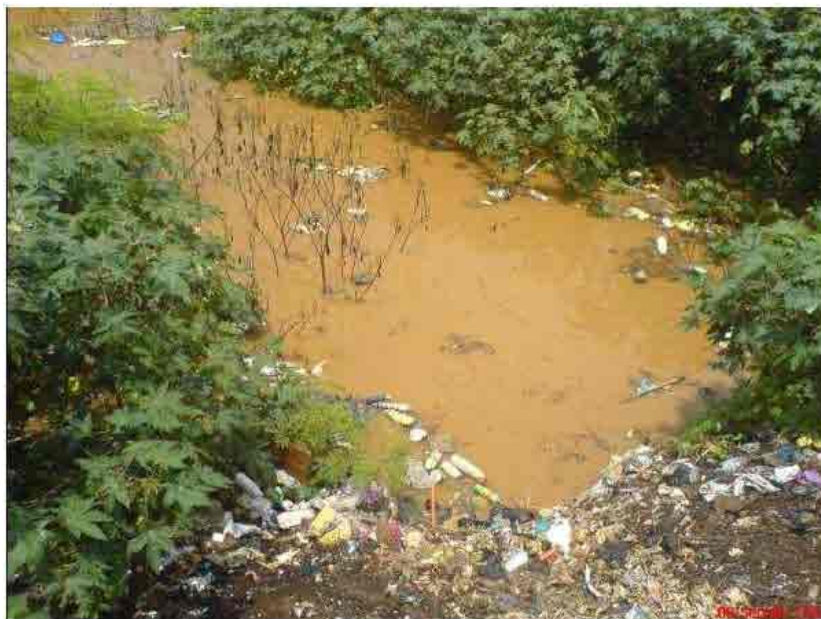
Figure 3.2 – Débouché du dalot sous la VDN.
