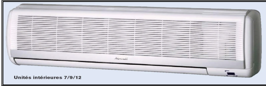
Figure 26:Unité intérieure du groupe de climatisation (Evaporateur).
