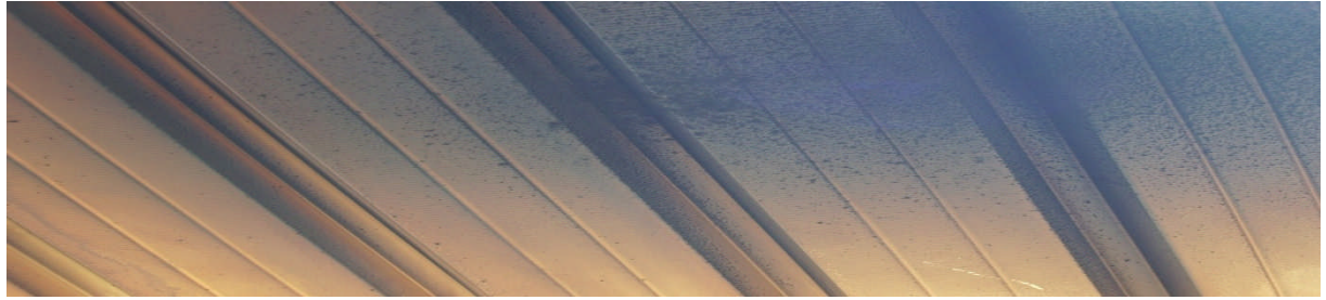
Figure 23:Toiture de local enfumée.
