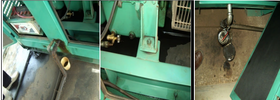
Figure 38:Contamination du sol et pots sauvages pour rétention huiles.
