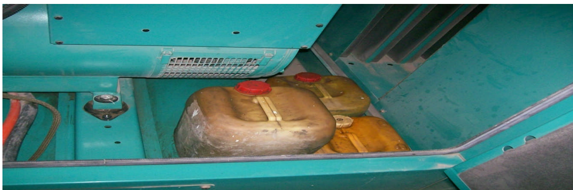
Figure 25: Dépôt de carburant dans le capotage du GE.
