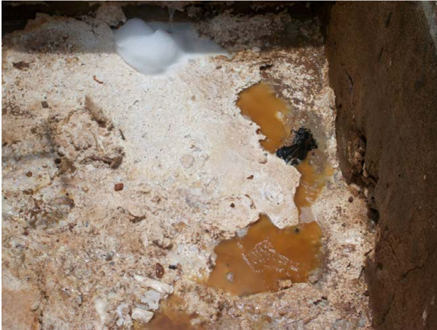
Figure 11 : Bassin de rétention des eaux usées (J.N. GUISSOU le 08/06/11)
