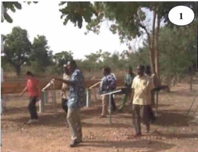
Le Site du Périmètre irrigué. Vue des installations des plaques solaires
