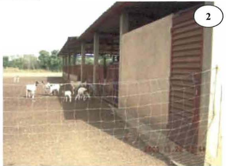
Le Site Elevage : vue du bâtiment abritant les petits ruminants (environ 200 têtes)
