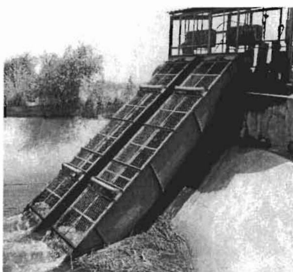
Photo n° 2: Vue d'une pompe à hydrovis Dembelé et Dissa, 2005
