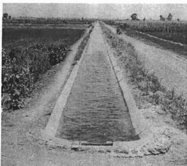
Photo n° 1 : Vue d'un canal primaire au Sourou
