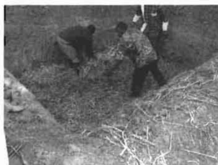
Remplissage de la fosse
