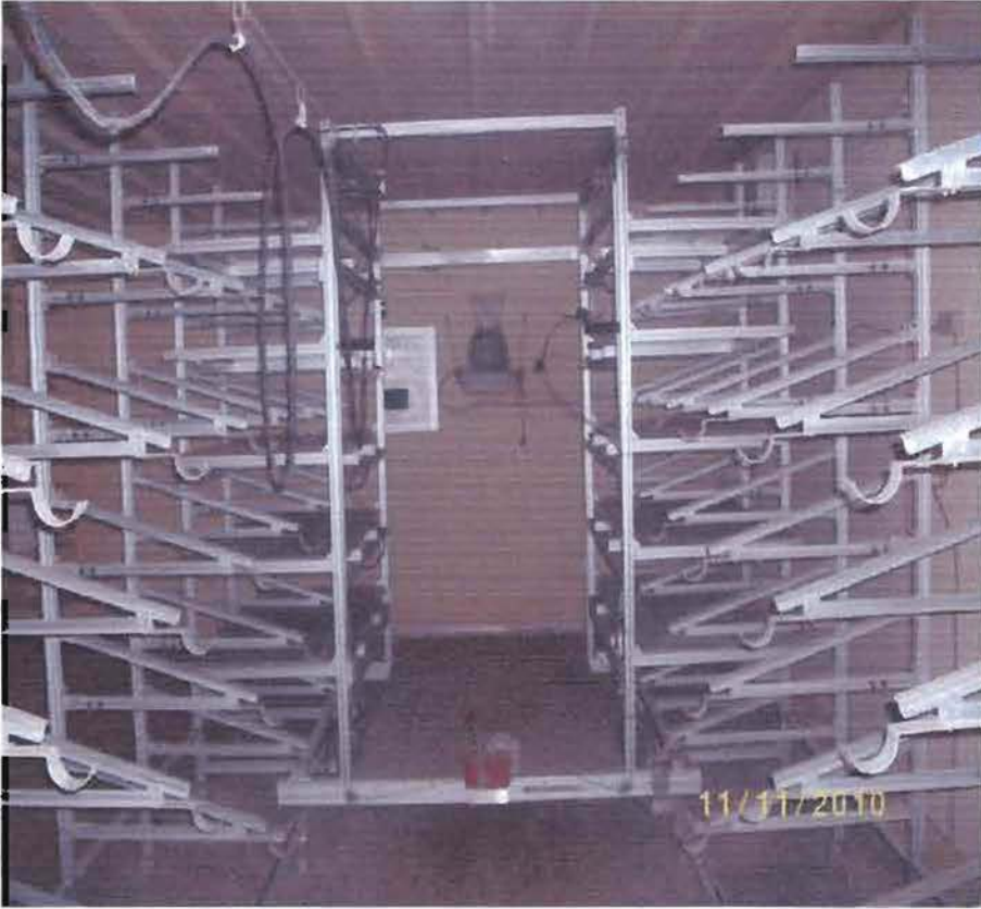
Figure 5 : Vue d'ensemble du TPU-3
