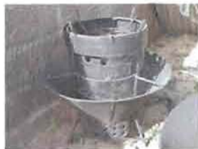
Photo n°2 : Modification de la hauteur du cylindre externe et de ses supports de maintien
