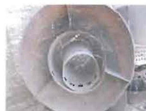
Photo n°24 : Destruction du cylindre central
