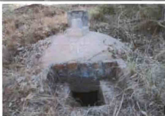
**Photo2** : Digester construit avec des briquettes en pierre de l'INERA-Farakoba au Burkina Faso
