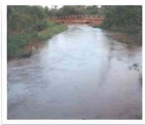
Photo 4: Une vue du lit après désensablement en 2012
