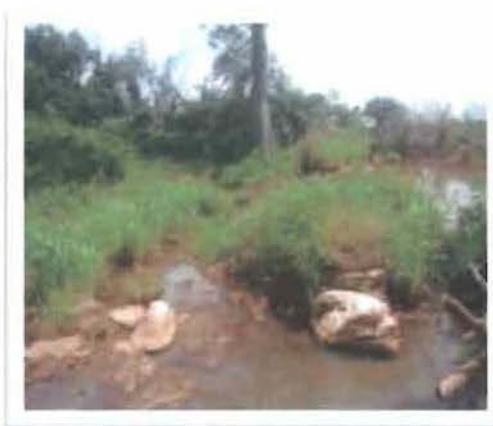
Photo 6 : État actuel de la digue de protection à la date du 08-10-2013
