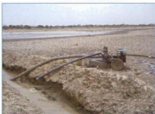
Photo 4: Rigole d'eaux de barrage(Boulmiougou)
