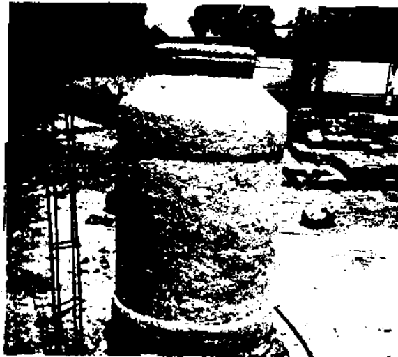
Photo n° 7 : Grenier en terre "type mossi" toujours. La forme cylindrique est plus nette ici. On remarque bien la dalle-couver- cle en terre. (Ouaga : Kamboinsé)
