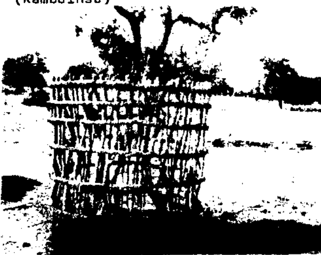
Photo n° 3 : Un exemple de squelet- te pour grenier cylindrique : les attaches sont réalisées avec des é- corces d' Adansonia digitata (Bomba- cacée) (Fada)
