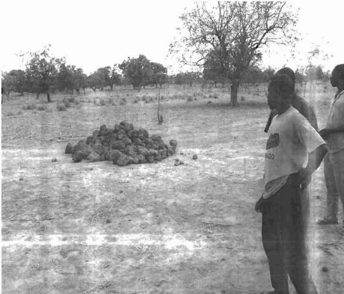
Photo 3 : Quelques moellons sur un site pour l'aménagement de diguettes dans le village de Barouli
