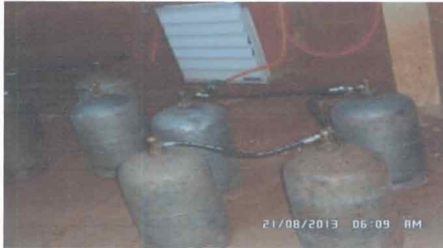
Photo 5 : Système d'alimentation du Tunnel
