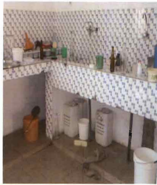
Salle de lavage du matériel (source : GBEKPON, 2013)
